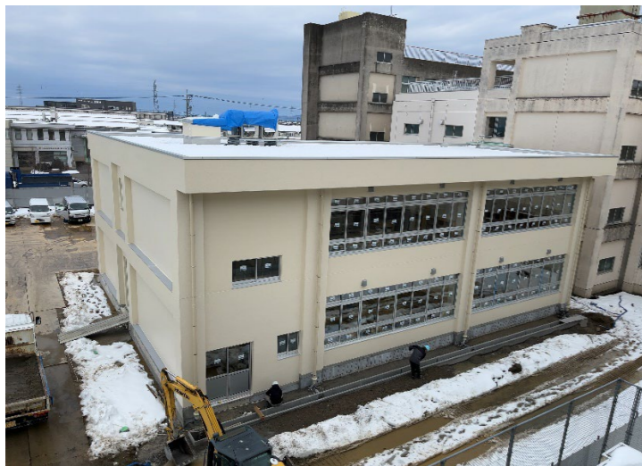
《定点撮影》外部足場解体完了 R5.12.25
