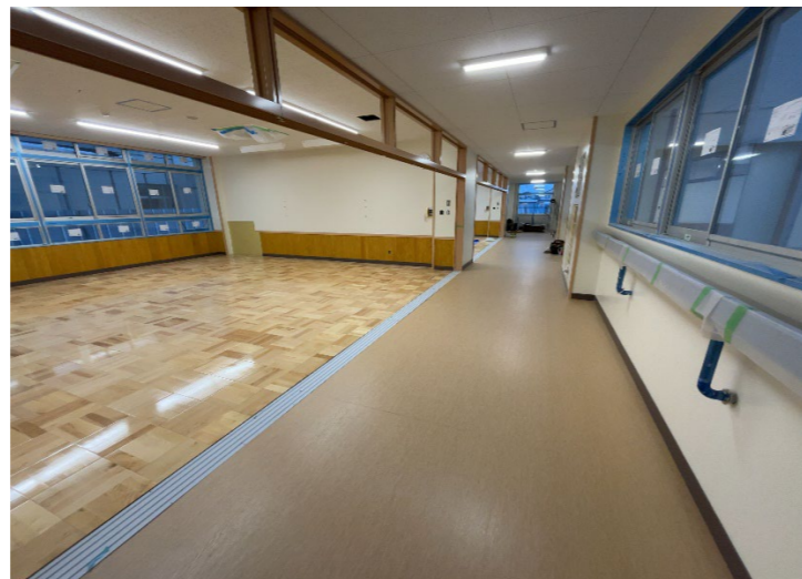
《定点撮影》1階内装工事中 R5.12.25
