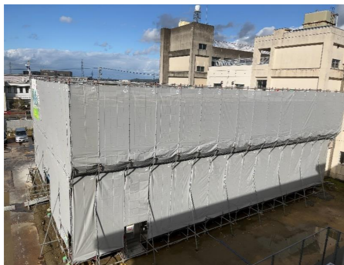
《定点撮影》外装工事中 R5.11.13
