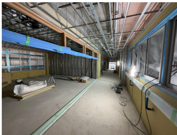
《定点撮影》1階内装工事中 R5.11.17
