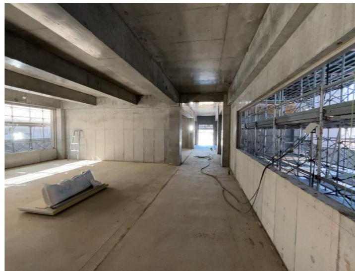
《定点撮影》 1階躯体工事完了 R5.10.19
