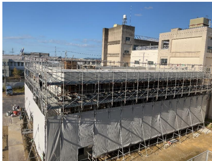
《定点撮影》 躯体工事完了 R5.10.13
