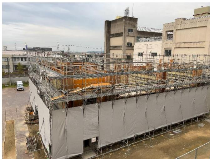
《定点撮影》2階鉄筋、型枠組立状況 R5.9.14
