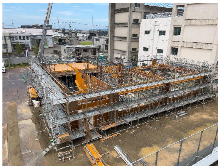
《定点撮影》1階鉄筋、型枠組立状況
