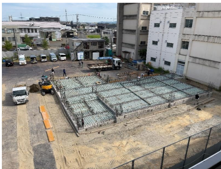
《定点撮影》基礎埋戻し完了、土間工事状況
