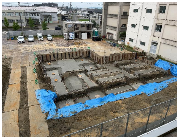
《定点撮影》杭打設、基礎掘削完了
