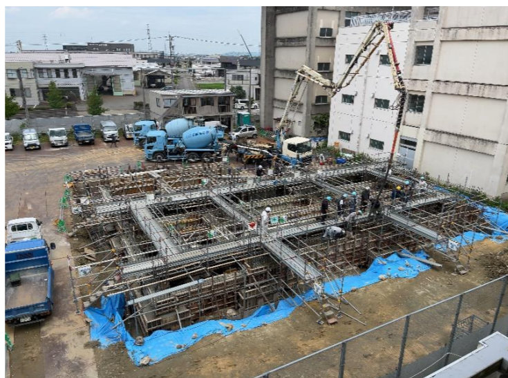
《定点撮影》基礎コンクリート打設状況
